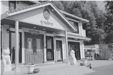
日本の住宅メーカーに発注し設立した寺院 （東京都八王子市にて筆者撮影、2022年3月）
