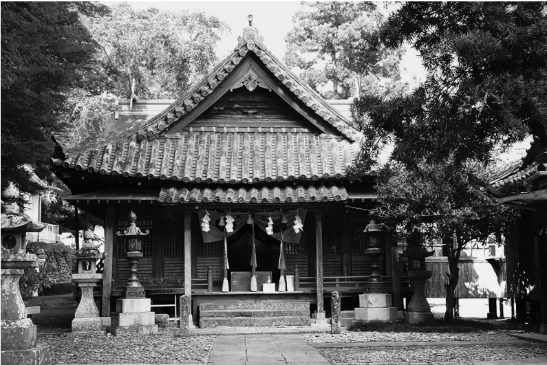
厳原八幡宮神社拝殿。背後に本殿の檜皮葺屋根見える
