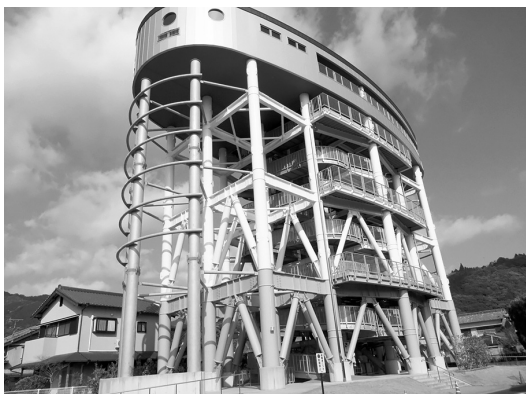
写真1 佐賀地区津波避難タワー(2020年3月25日筆者撮影)
