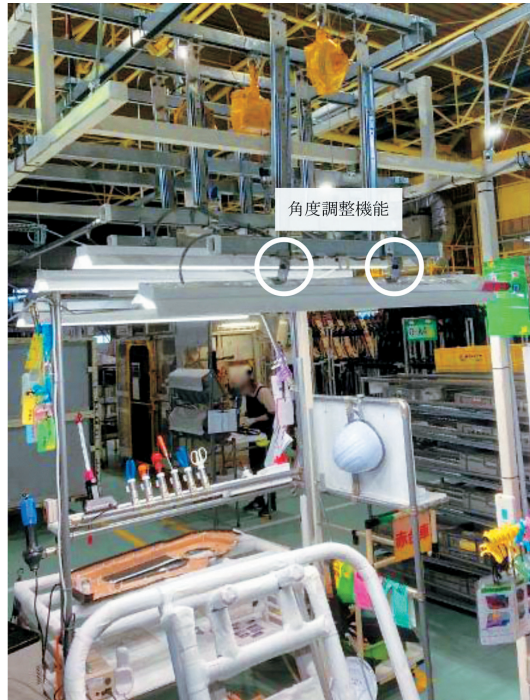
図8 検査台の照明の角度調整
