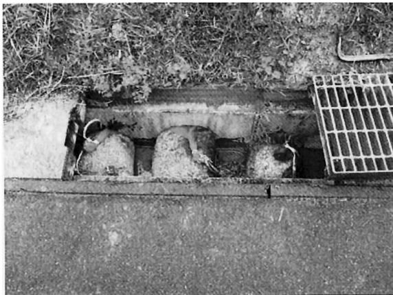
写真 4.3 道路側溝に置かれたゼオライトのネット袋詰（3個設置してあるのは、それぞれ、泥水を止めて、溜めて、上澄みを流すため）
