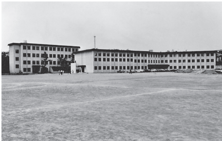
完成した法学部棟（グラウンドから）
