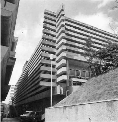
校倉造りが印象的な当時の図書館本館
